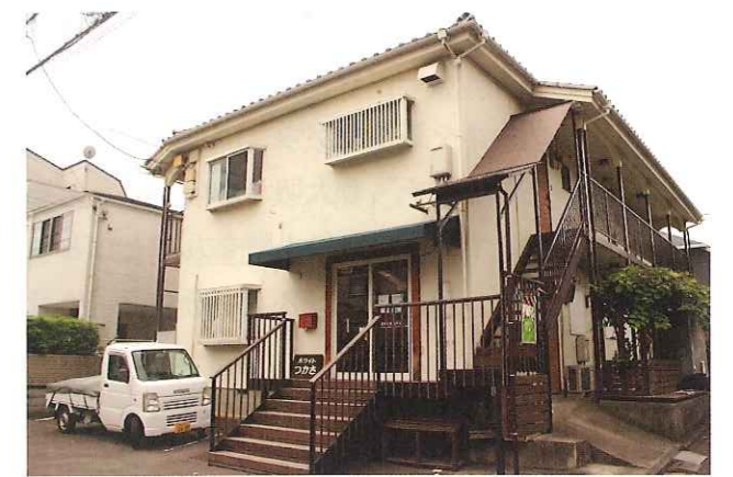
アパートの外観
