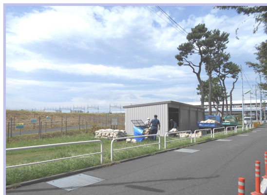
たまがわほんえん め まえ どのう せつ 玉川本園の目の前に土嚢ステーションが設 置されました
